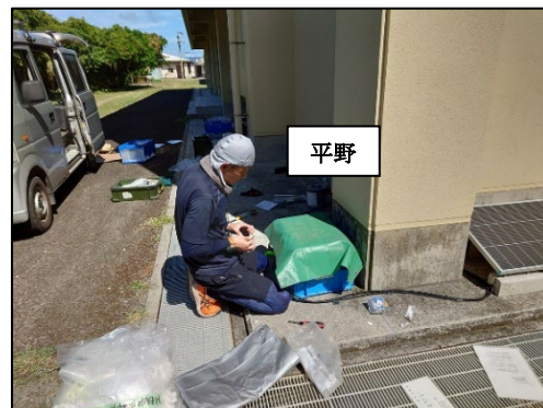
小宝島テレメータ観測点設置
