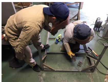
図8 栽培棚の製作（溶接作業）
