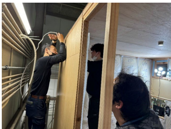
海洋波動実験等の実験小屋の電気工事
