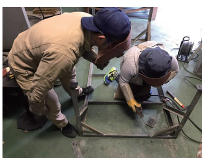
図2 栽培棚の製作(溶接作業)
