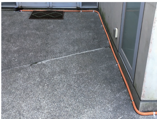
写真3 ネットワーク配線作業
