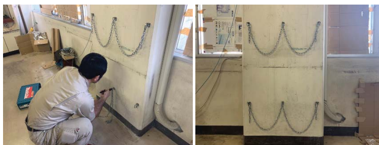
図 1 高圧ガスポンペを固定するためのチェーンを設置
