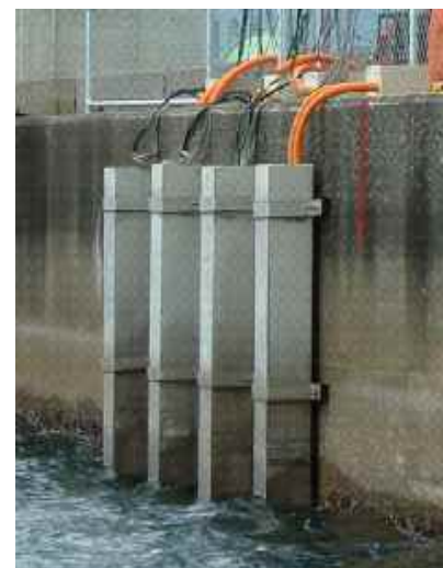
図-2 供試体曝露状況
