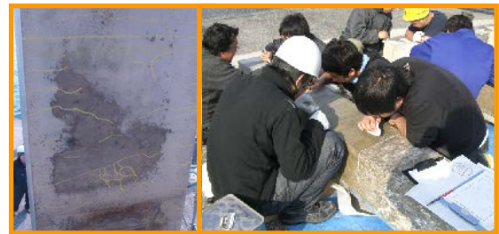
図-4 外観調査（ひび割れ観測）
