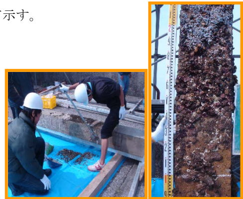
図-3 外観調査（付着生物除去）
