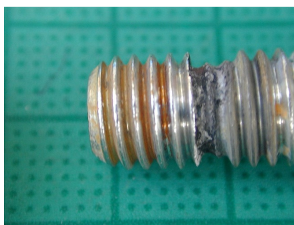
図-6 腐食したボルト
